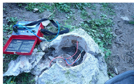
图 11 4 # 钻孔的多点位移计及智能综合测试仪图
